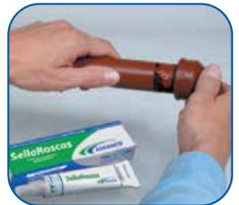
**04.** **Mécanica:** coloque sella roscas Amanco en todo el contorno de los primeros filetes. Una vez roscado, conforma una junta elastomecánica, atóxica y altamente resistente a la presión y las altas temperaturas.
