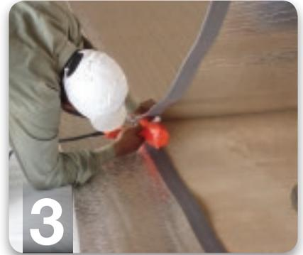
En estos casos es conveniente termosoldar varios rollos en el piso y luego instalarlos alineándolos a la estructura existente.
