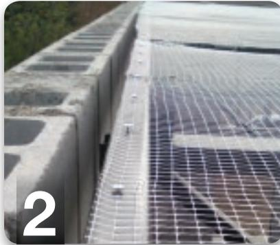
Los rollos de RED 2x2 se tensan y se fijan con tornillos autoperforantes.
