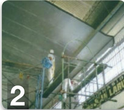
Los rollos se colocan pasándolos alternativamente por arriba y por debajo de los alambres, para evitar que la membrana flamee.
