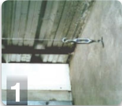
Se colocan alambres galvanizados, tensados perpendiculares al sentido de las chapas. La separación entre alambres deberá modularse entre 40 a 60 cm.
