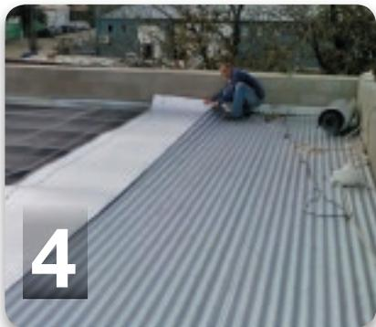
La membrana se fija conjuntamente con la chapa, con tornillos autoperforantes. Se continúa con el ciclo hasta completar la totalidad de la cubierta.
