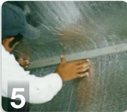
Se fija o se atornilla con listones o perfiles un lateral de la membrana al muro o a la estructura existente. Luego se tensa la membrana suavemente y se fija el segundo lateral repitiendo el proceso.
