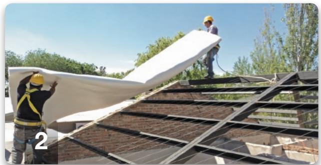
Sobre las correas se instala la RED 2x2 de ISOLANT o bien se arma un entramado romboidal de alambre galvanizado de 30 cm de lado. Luego se coloca la membrana ALU FUSION 10 con la **cara de aluminio hacia arriba**.
