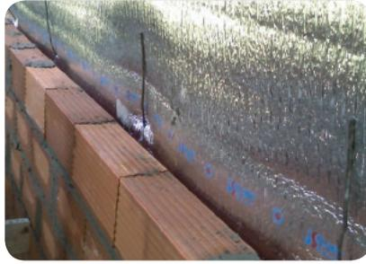
**Además del uso de muros dobles para mejorar el acondicionamiento térmico, se puede reforzar la aislación con el uso de las membranas ISOLANT.**
