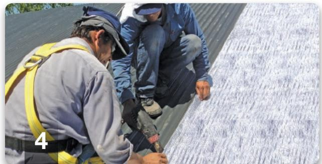
Se repite todo el ciclo hasta completar la cubierta, **termosoldando las uniones con pistola de aire caliente para asegurar la aislación térmica continua y hermética**. La termofusión de las uniones se puede realizar tanto en el piso como sobre la estructura.
