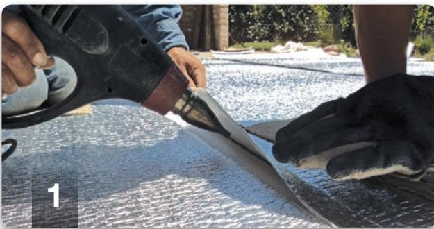
Recomendamos termosoldar varios rollos (2 ó 3) en el piso para facilitar la colocación posterior y ahorrar tiempos de instalación.
