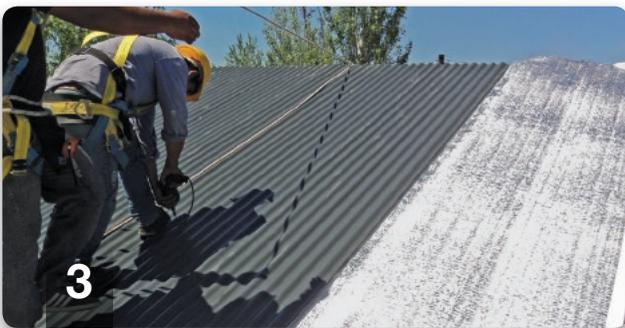
Los rollos de ALU FUSION 10 se colocan en el mismo sentido que las chapas y se fijan junto a éstas por medio de tornillos auto-perforantes.
