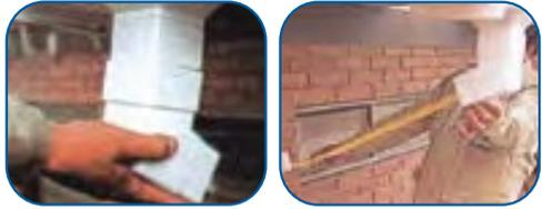
• Corte el tramo de bajante, ensámblelo y fije el soporte al muro con tornillos inoxidables y chazos plásticos. Para continuar la instalación corte los tramos de bajante a la longitud necesaria, deje 6 mm entre la bajante y la unión o codo para la expansión térmica.
