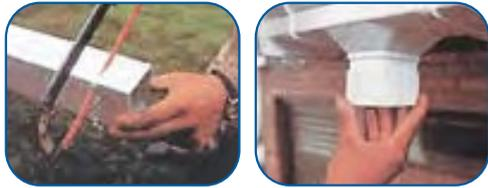
• Ensamble un soporte a otro codo y apóyelo contra el muro alineado la campana de este segundo con el espigo del otro. Mida la longitud de bajante que necesita para unir los dos codos.
