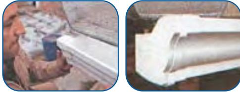
Es la que se hace cuando la canaleta requiere ser suspendida de la teja, bien porque ésta sobresale mucho de la fachada, o porque el muro es irregular y no permite alinear bien los soportes. Para ello, se deben utilizar los soportes colgantes metálicos. Siga los siguientes pasos:
